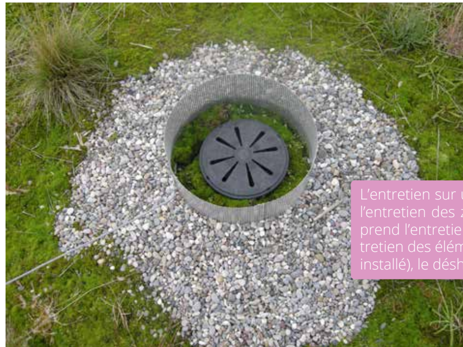
Assurez-vous que les sorties de drainage soient débarrassées de toute végétation. ©Jonatan Malmberg
