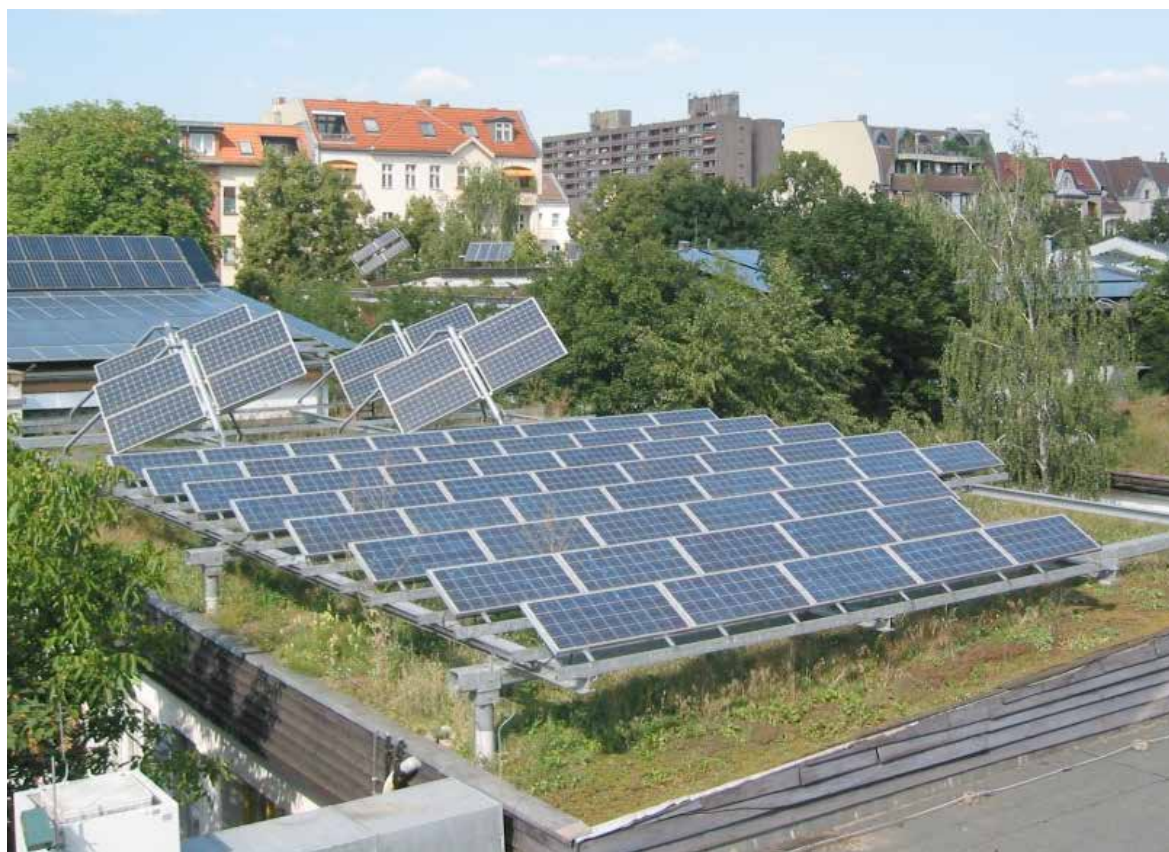
Côté gauche: panneaux maintenus par le poids du béton © http://www.energieagentur.nrw.de , côté droit: système de support couvert et maintenu par le poids du substrat
