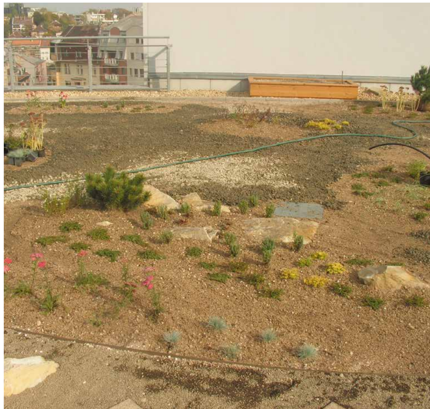
Irrigation sur une toiture végétale extensive à la biodiversité riche. ©Vera Enzi
