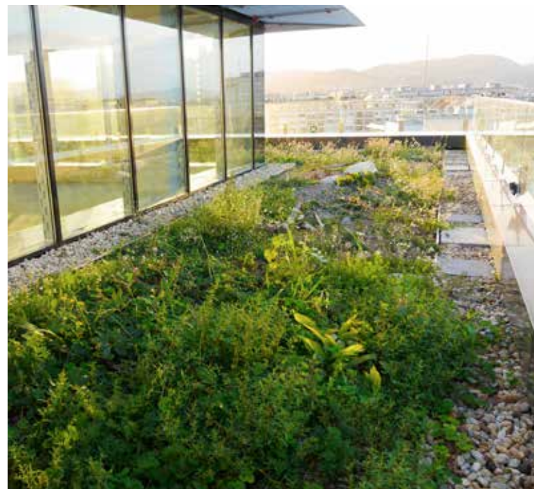
Une toiture végétale à biodiversité riche semi-intensive à Budapest. ©Jonatan Malmberg
