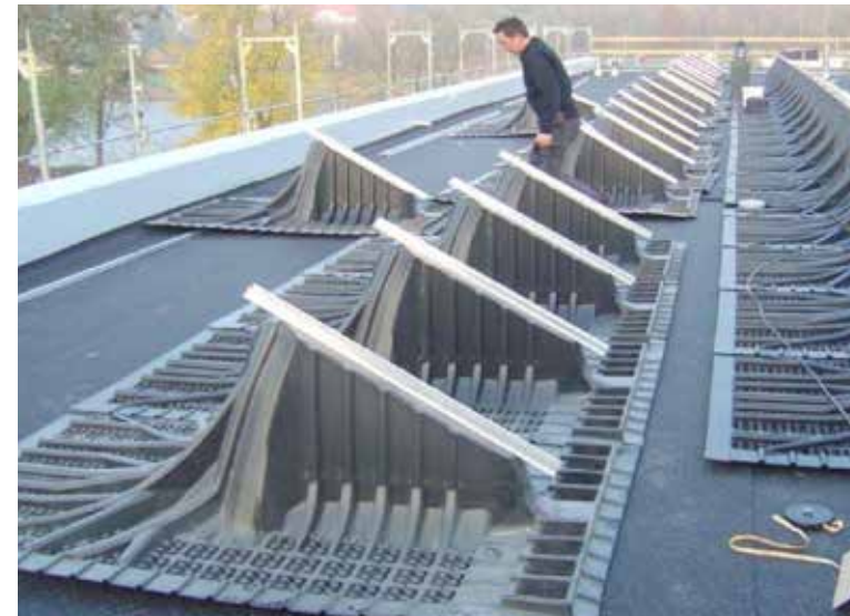
Un type de panneau solaire pour toiture végétale. ©Optigreen International AG
