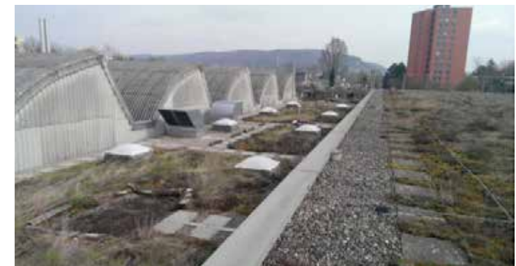
Zones sans végétation tout au long des bords pour empêcher le soulèvement dû au vent. ©Vera Enzi
