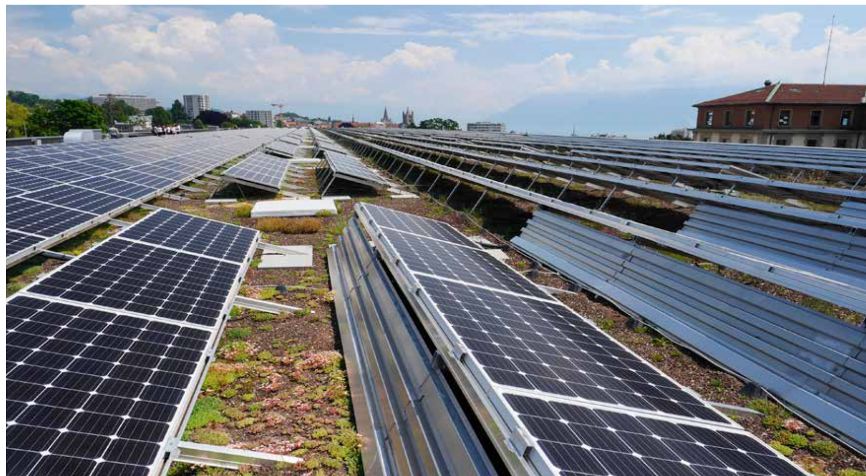
Toit bio solaire à Lausanne. © Jonatan Malmberg
