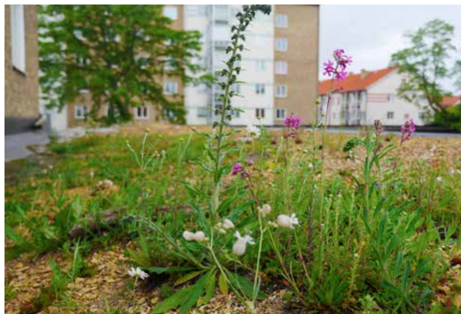
Toiture végétalisée légère à Malmö, Sweden. ©Jonatan Malmberg
