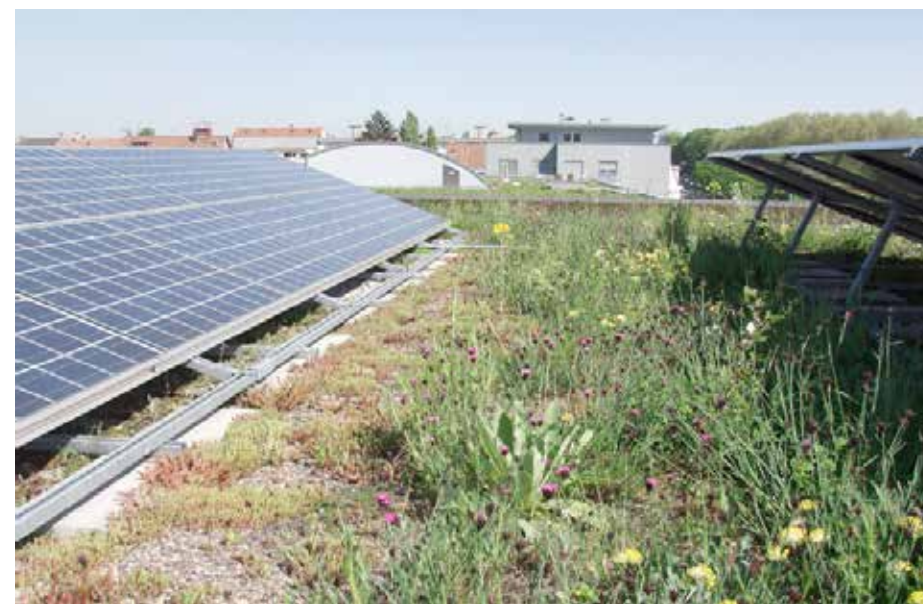
Toit bio solaire offrant différentes nuances d'ombrage pour la végétation ©Zürich Université des Sciences Appliquées ZHAW
