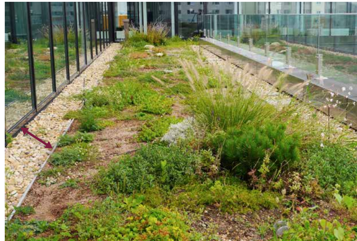
Bandes de cailloux pour des raisons de sécurité incendie. ©Jonatan Malmberg
