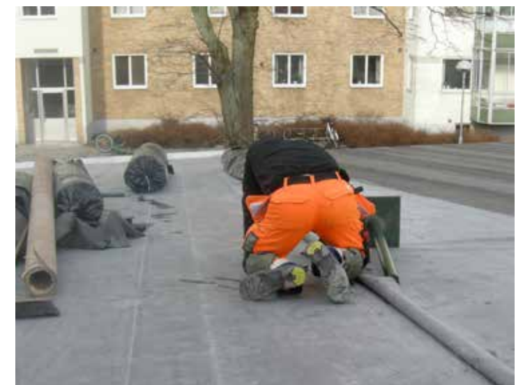
Installation de la membrane d'étanchéité. ©Jonatan Malmberg
