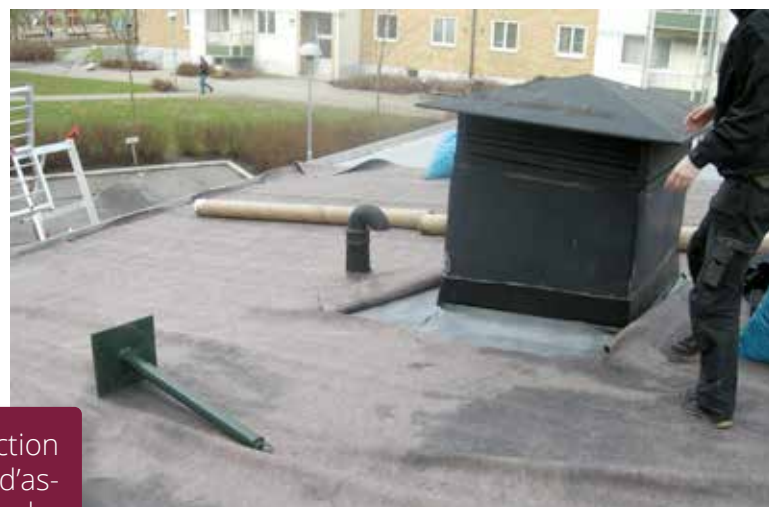
Géotextile sur la couche d'étanchéité. ©Jonatan Malmberg
